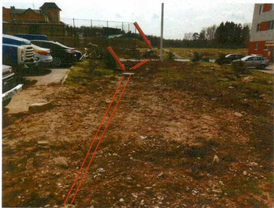
Фото 2.4. Общий вид от дома Парковая, 1а. Имеются следы (вскрытие асфальта, земляные работы) после выполненного ранее ремонта сети от дома к колодцу КК-3 и далее к колодцу КК-4, перекладки параллельной трубы ПВХ – благоустройство придомовой территории после ремонта не выполнено;
