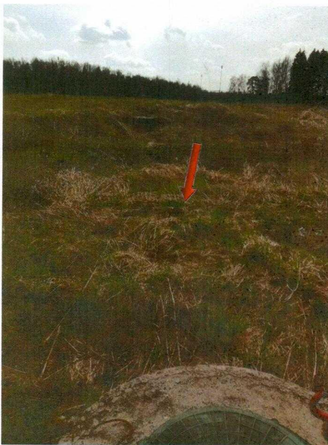
Фото 2.17. Устройство КНС у колодца №5 (КК-5) не выполнено.
